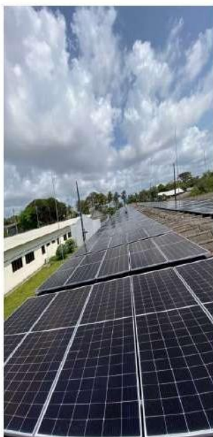
Figura 4 – instalação de usina fotovoltaica em edificação do HARF, viabilizando redução no consumo de energia elétrica do complexo HARF-OARF.
